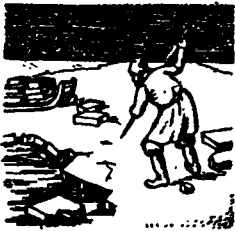
Er bricht Eisblöcke.
